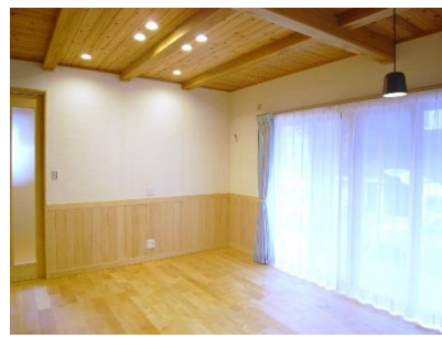
LDK 壁漆喰塗り(カルクウォール) 腰板貼 天井杉板
