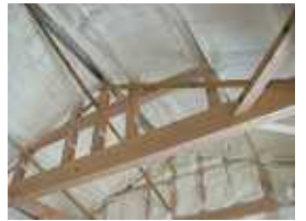
断熱材アクアフォーム吹付状況
