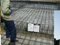
基礎配筋チェック
