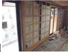
耐力壁を設け断熱材貼
