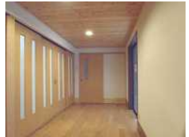
完成 【縁側】正面がキッチンへ通じる戸サッシにはペアガラスを使用壁部分を新設し耐震を強化
