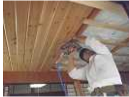
天井造作中(断熱材あり)
