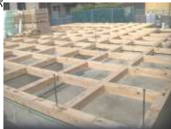
【平戸橋町K様邸の土台敷写真】 マルスでは土台・柱すべてヒノキ使用
