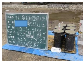
コンクリート受入検査
