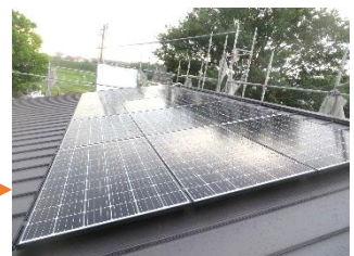
太陽光発電システム
