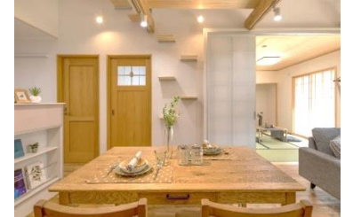
和室との間仕切りにはアルミ製建具使用
