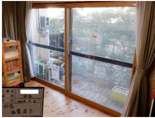
洋室サッシに内窓取付 補助額 84,000 円
