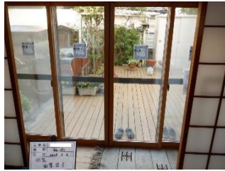
縁側サッシに内窓取付 補助額 84,000 円
