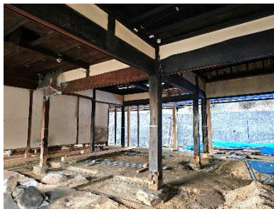
当社リノベーション工事写真
