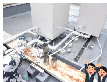
新しい2台の温水器の 配管を接続して完成です
