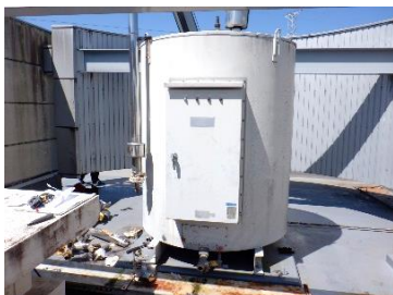
古い温水器の配管をすべて取外し
