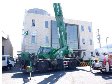
レッカー車で吊り上げます
